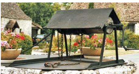
La solution le plus généralement employée pour y remédier fut de fixer sur la potence ou directement sur la margelle (mais, dans ce dernier cas, la poulie devenait inutile) un treuil mu par une manivelle (ou tout autre mécanisme qui réduisait l'effort à fournir) sur le tambour duquel (tambour en bois ou en métal) s'enroulait le câble ou la chaîne.
