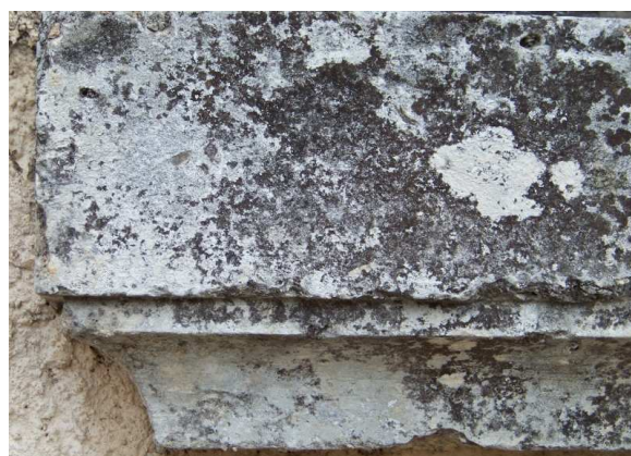
Détail de l'appui des fenêtres
