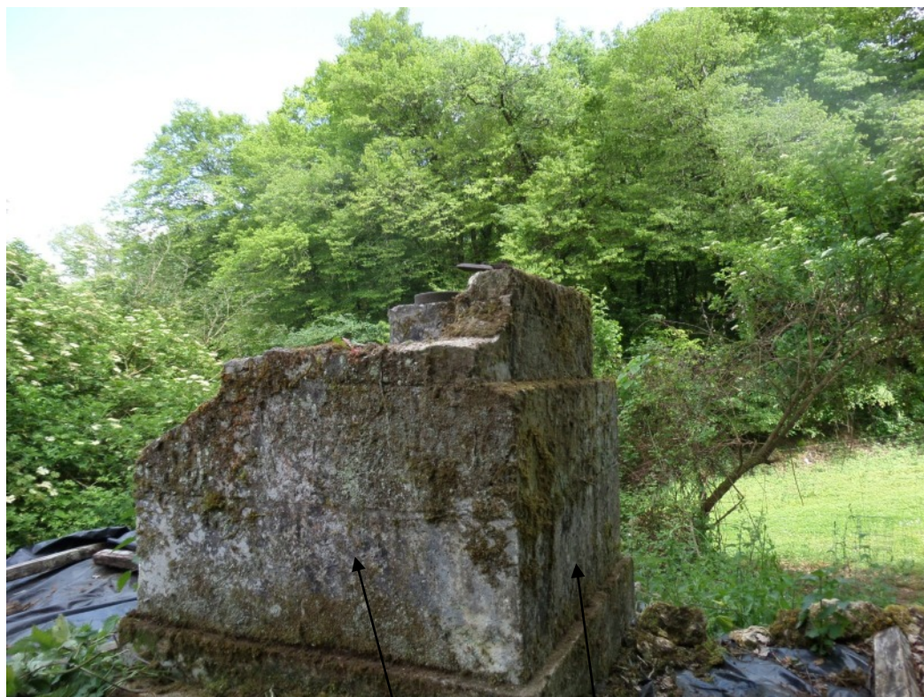
Angle du mur ouest et sud
